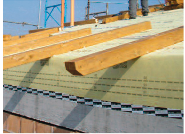
Figura 4.24b – In vista il telo di tenuta interna e freno al vapore, posto sopra al tavolato strutturale, nastrato sul cordolo in cemento armato
