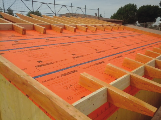
Figura 4.24a – In vista il telo di tenuta interna e freno al vapore igrovariabile, posto sopra al tavolato strutturale: tra breve sarà nastrato alla parete verticale in xlam
