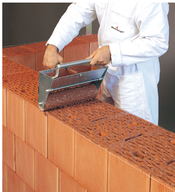
Figura 3.23 – Una parete in fase di realizzazione, con sottilissimi giunti di malta termica stesi a tramoggia con rullo
