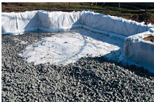
Figura 4.76 – Il fondo dello scavo viene “foderato” con tessuto-non-tessuto, quindi si comincia lo spandimento del vetro granulare. Si noti la presenza del tubo dreno lungo in perimetro dello scavo, anch'esso avvolto da tessuto-non-tessuto filtrante
