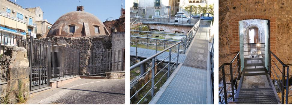
Fig.03 Il sito archeologico delle Terme della Rotonda a Catania: passerelle in acciaio per i percorsi accessibili.
