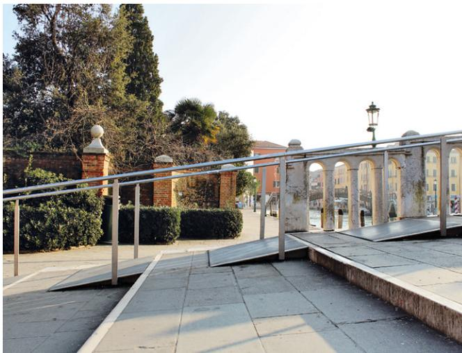
Fig.01 Ponte Papadopoli: vista delle pedane inclinate amovibili metalliche appoggiate sui gradini del ponte poste in opera nel 2014. I montanti, realizzati con due piatti di acciaio avvitati e agganciati alle pedane, sono collocati in corrispondenza dei "pieni" del parapetto originario in pietra d'Istria, e il corrimano, realizzato con tubolare in acciaio e sorretto dai montanti, segue perfettamente il disegno del parapetto. R.Revellini
