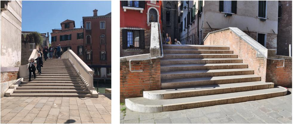
Fig.04 Esempi di inserimento di corrimano in acciaio al parapetto esistente. Nel primo caso il corrimano viene curvato per essere fissato a terra ed evitare fissaggi sulla pietra d'Istria (a). Nel secondo, il corrimano, prolungandosi sulla scalinata a ventaglio, viene agganciato alla muratura laterale (b). *R.Revellini*
