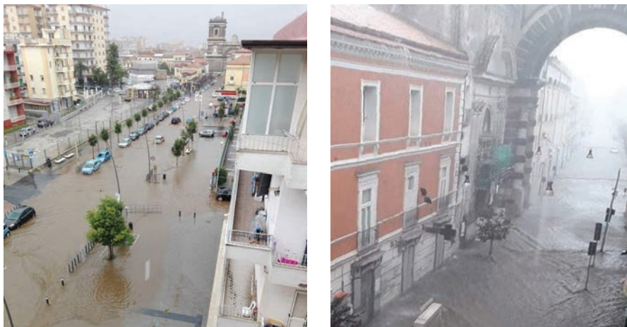
Fig.1. Allagamenti alla Porta Napoli, Aversa (CE) (novembre 2017 e settembre 2019) (fonte: ricerca PRIN 2015).
