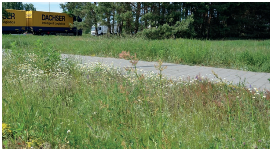
Fig. 9. Berlino, trincee vegetate per la gestione sostenibile delle acque meteoriche nel quartiere di Adlershof (Foto: F. Dell'Acqua, 2018).
