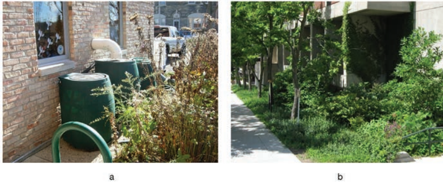
Fig. 5. Soluzioni per la ritenzione delle acque di copertura degli edifici: a) barili in plastica riciclata - Urban Ecology Center, Milwaukee, Wisconsin, 2012; b) rain garden al piede dell'edificio (fonte: Aaron Volkening, from Flickr.com; DASonnenfeld via Wikimedia Commons).
