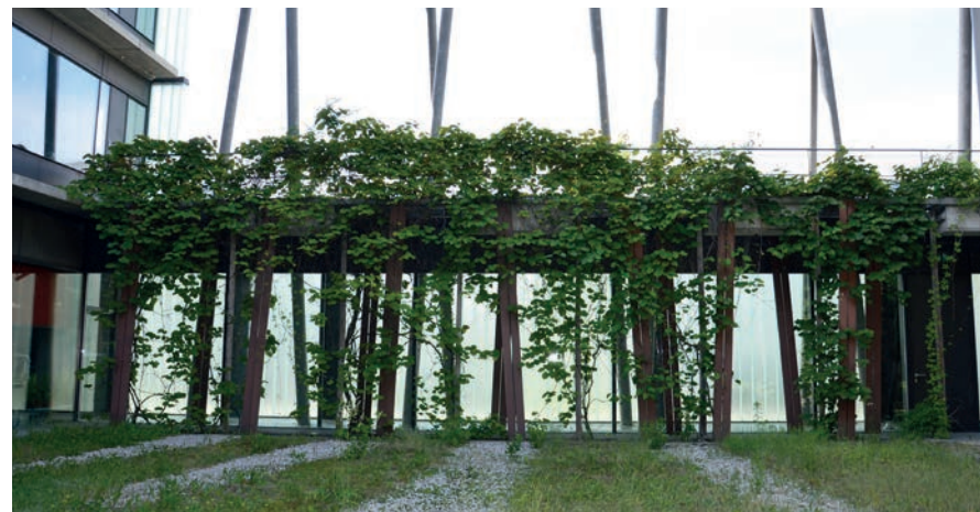
Fig. 10. Berlino, quartiere Adlershof, Istituto di Fisica della Humboldt-Universität, soluzioni nature-based per la gestione sostenibile delle acque meteoriche (Foto: F. Dell'Acqua, 2018).
