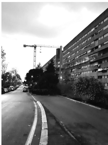
Fig. 2: Lavori in corso al Piano Libero (fonte: foto degli autori)
