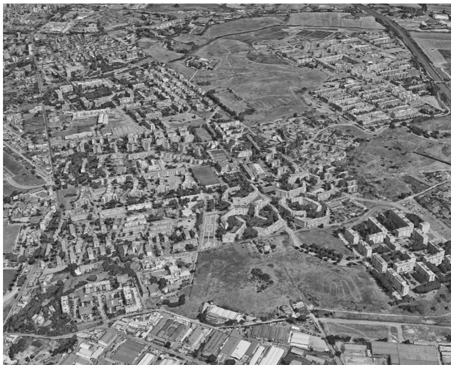
Fig. 4: Vista dall'alto del Quartiere UNRRA Casas San Basilio (fonte: Google Maps)
