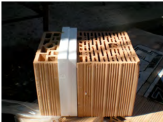
13 | Liceo Scientifico Majorana: Blocco in laterizio preassemblato utilizzato nei tamponamenti verticali Majorana School: Brick Bloch that we used to make the walls
