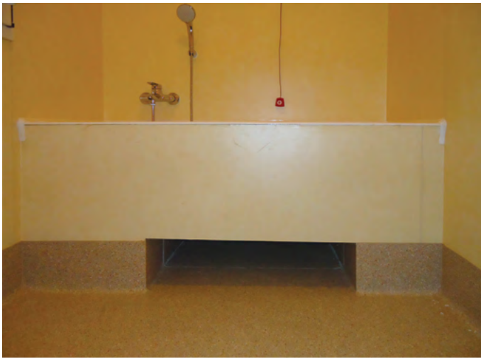
04 | Particolare dell'incavo sotto la vasca che permette l'utilizzo del sollevatore portatile Detail of the recess under the bathtub that allows the use of the hoisting equipment
