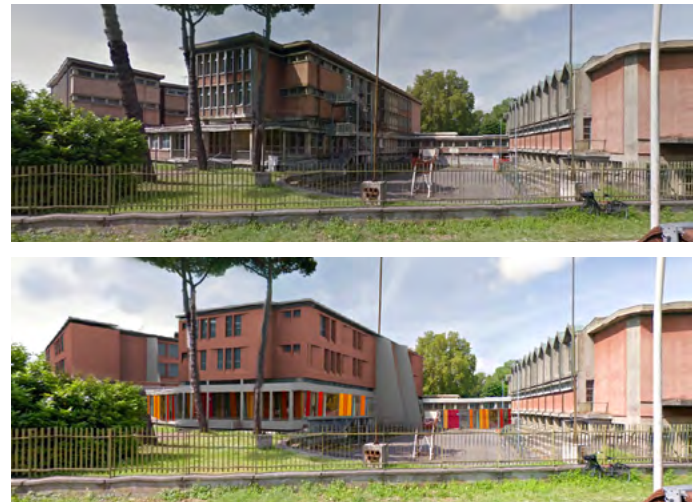
08 | ITC Carrara: edificio prima e dopo l'intervento di riqualificazione Carrara School: Building before and after energy retrofit
