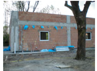
16 | Liceo Scientifico Majorana: Fase di cantiere. Prospetto nord Majorana School: construction of north façade
