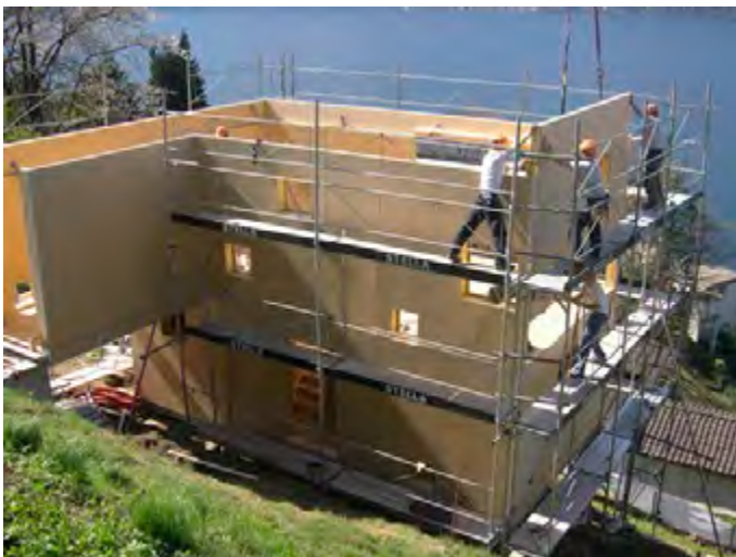
08 | Wespi de Meuron Romeo Architetti, Casa prefabbricata di legno a Caviano, assemblaggio della casa prefabbricata, foto di Wespi de Meuron Romeo Architetti
