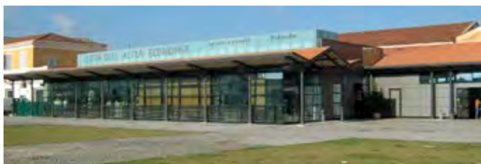
03 | La Città dell'Altra Economia nell'area dell'ex Mattatoio a Roma The Città dell'Altra Economia in the former Mattatoio, Rome
