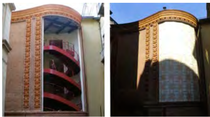
04 | Roma, monumento a Vittorio Emanuele II. La nuova torre ascensore, autonoma staticamente e matericamente nei confronti della preesistenza, è collocata nella zona retrostante del monumento, rendendo visibile solo il torrino terminale che emerge soprattutto guardando dall'area archeologica zona dei Fori, foto di Andrea Pane
