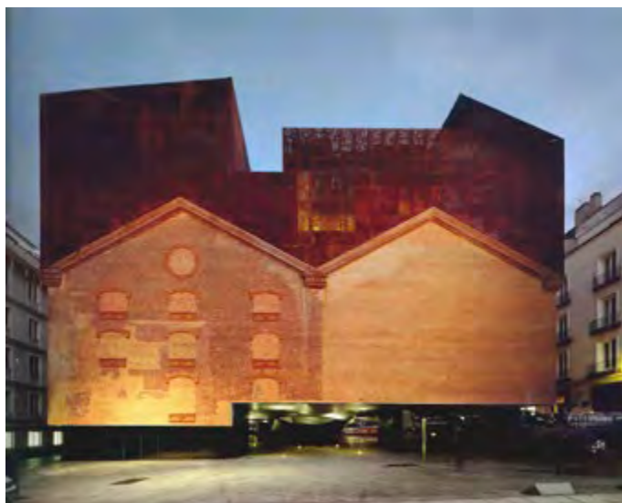
02 | Addizione+Svuotamento/J. Herzog, P. de Meuron, Caixaforum, Madrid (2008)
