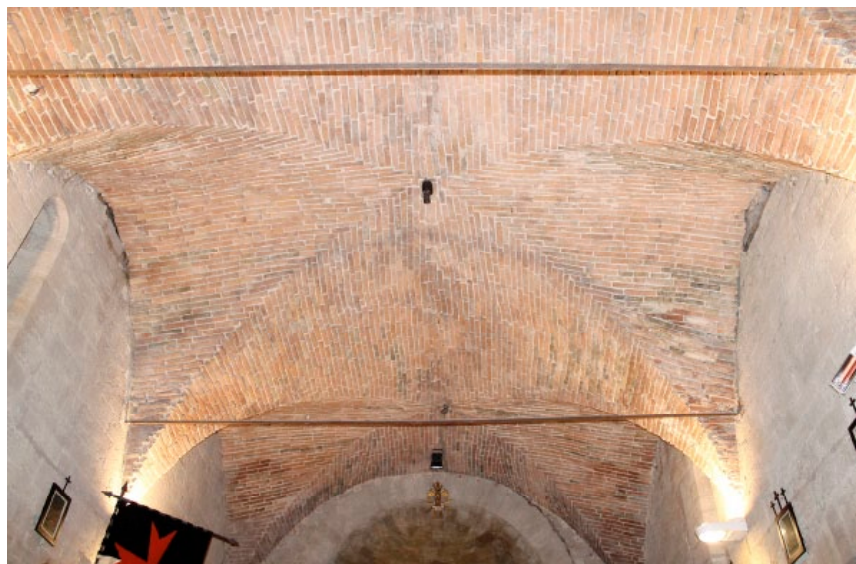
03 | Volta a tre crociere della chiesa, foto di A. Sichi e C. Rosini Three groined vault of the church, photo of A. Sichi and C. Rosini
