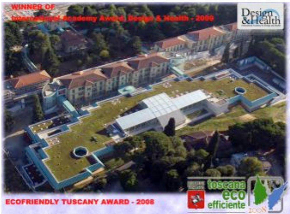
08 | L'ospedale pediatrico Meyer a Firenze: ristrutturazione ed ampliamento di Villa Ognissanti Meyer children Hospital in Florence: refurbishment and expansion of Villa Ognissanti
