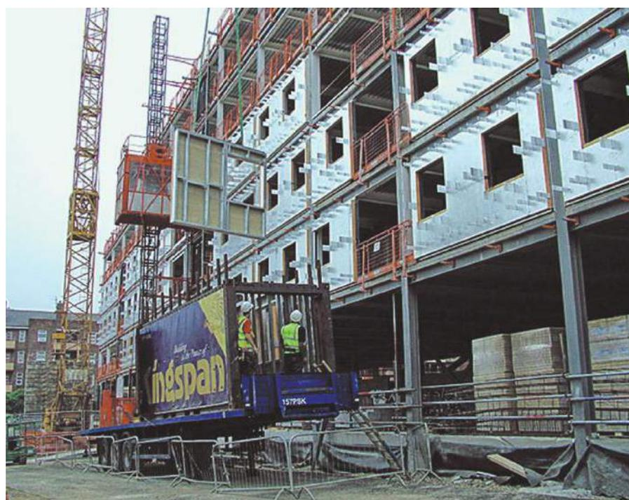
Il sistema costruttivo dell'edificio di Hounslow è composto da travi e pilastri in acciaio e pannelli leggeri (rivestiti in Alucobond) per i tamponamenti di facciata, che vengono montati già completamente prefiniti, serramenti compresi (Foto: Kingspan)
