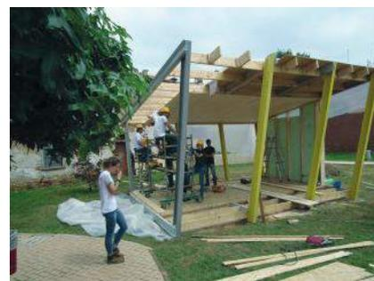
*Modulo Stone 2.0 ad Abbiategrasso – Modulo in costruzione: si possono apprezzare gli elementi strutturali in fibra di vetro e l'isolamento nelle pareti*
