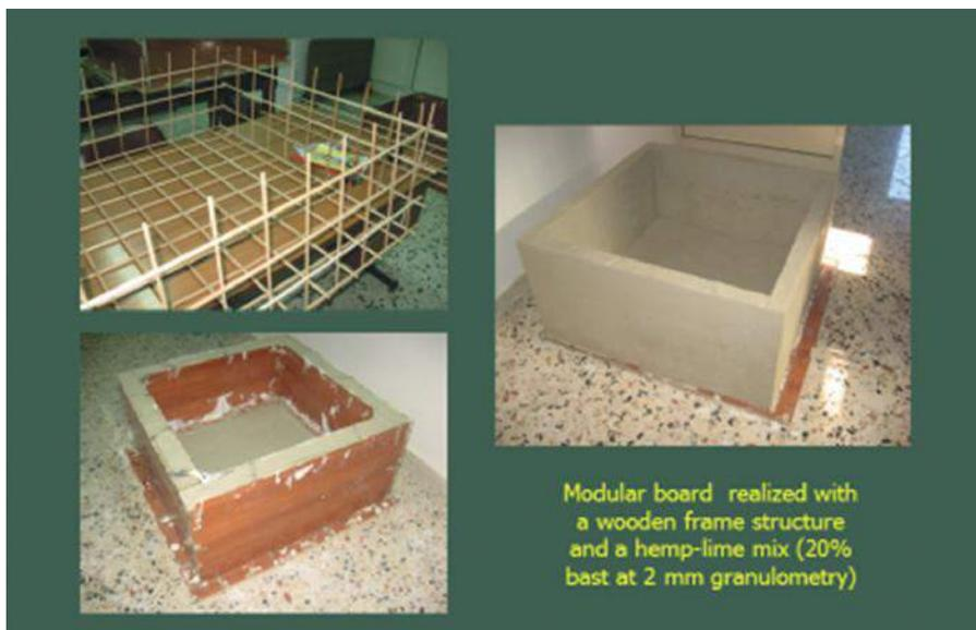
Figura 1. Realizzazione di un contenitore modulare per coperture a verde
