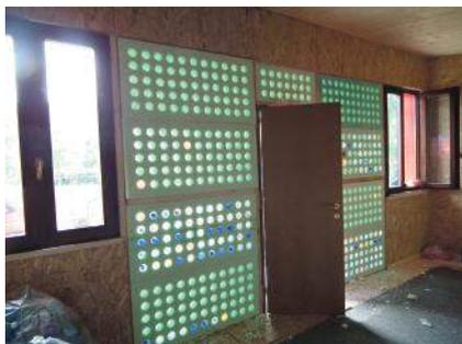
*Modulo Stone 2.0 ad Abbiategrosso – Vista interna del muro solare ad acqua realizzato con bottiglie di recupero riempite di una soluzione di acqua e alcool per l'accumulo del calore da fonte solare*
